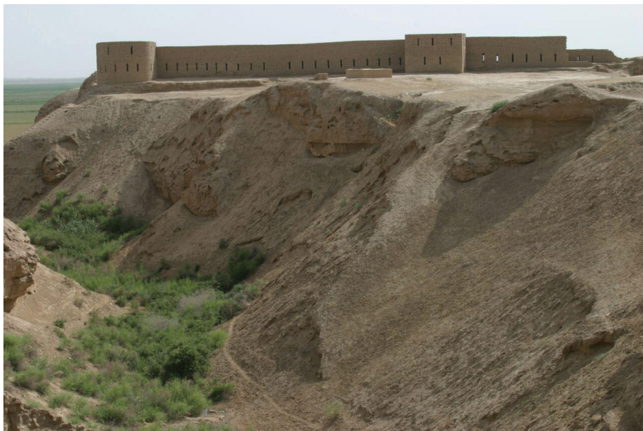
Кампыртепа. Северо-восточный угол городища. Крепостная стена кушанского периода после реставрации.
